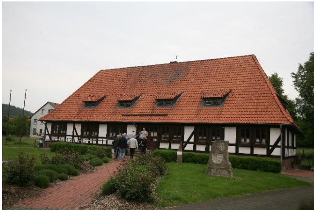
Gemeindezentrum des Ortsteils Lippoldsberg
