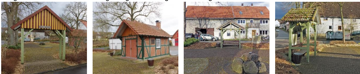
Dorfplatz: Lage zentral im Ort, Ausstattung mit Brunnen, Backes, Sitzgelegenheiten und Pavillons. Stellenweise Sanierungsbedarf an den Holzbauten
