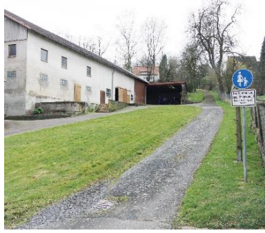
Fehlende Barrierefreiheit beim Zugang zur Kirche, Schäden an der Wegeoberfläche beim steilen Fußweg zum Grillplatz
