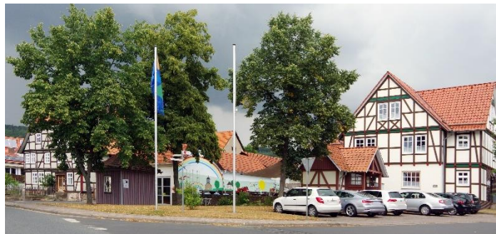
zentraler Bereich an der Ortsdurchfahrtsstraße
