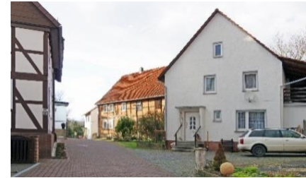
Im Zuge vorheriger Dorferneuerungsmaßnahmen sanierter Straßenraum
