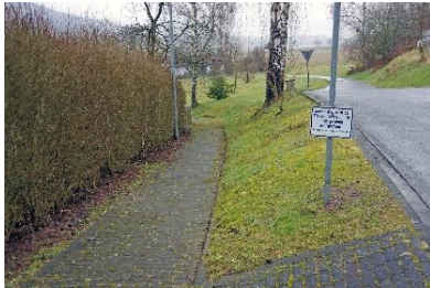
inzwischen teilsanierte Fußwege- verbindung zum DGH
