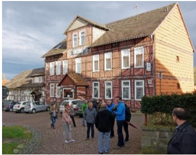
seit 2013 leerstehende Gastwirtschaft im Ortszentrum: Saalbau, Wirtshaus mit Fremdenzimmern
